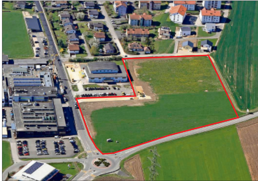
Bordant la halle polyvalente de Glovelier, la zone d'activités des Montates (entourée en rouge) est desservie par une route dédiée, ici encore en construction.
